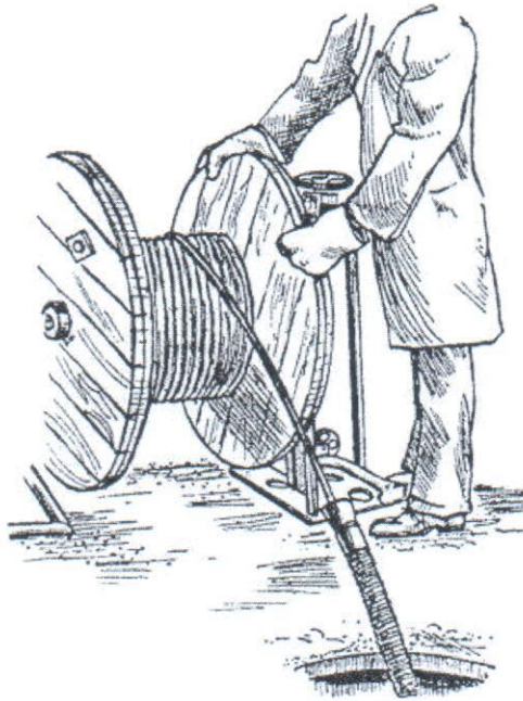
Рис. 13. Размотка кабеля с барабана во время прокладки.
