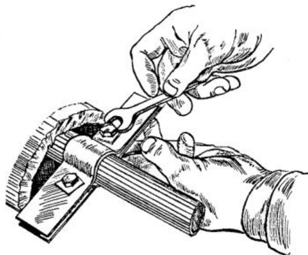
Рис.9. Установка противоугона.
