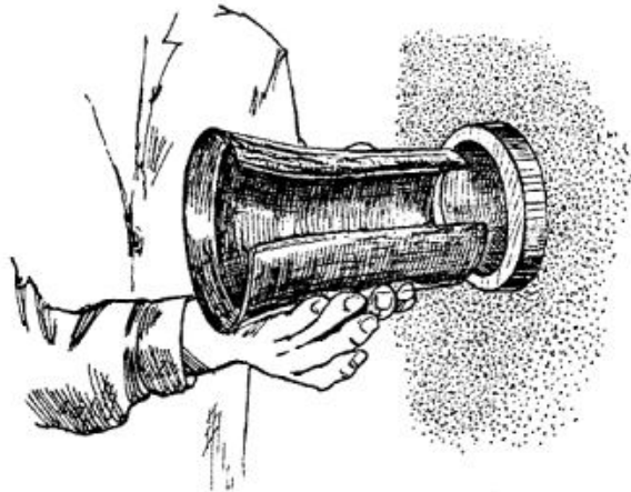
Рис. 13. Установка направляющей воронки на трубу канала кабельной канализации.
