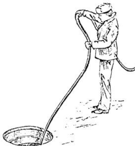
Рис.6. Прокручивание трубы при прокладке по каналу кабельной канализации.
