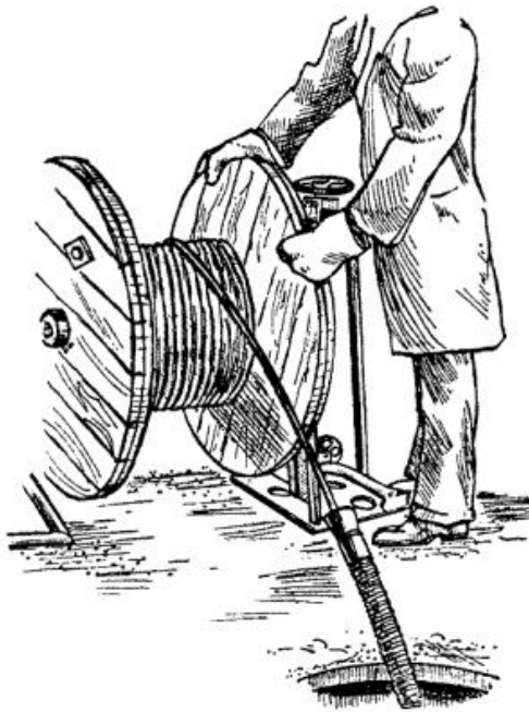
Рис. 13. Размотка кабеля с барабана во время прокладки.
